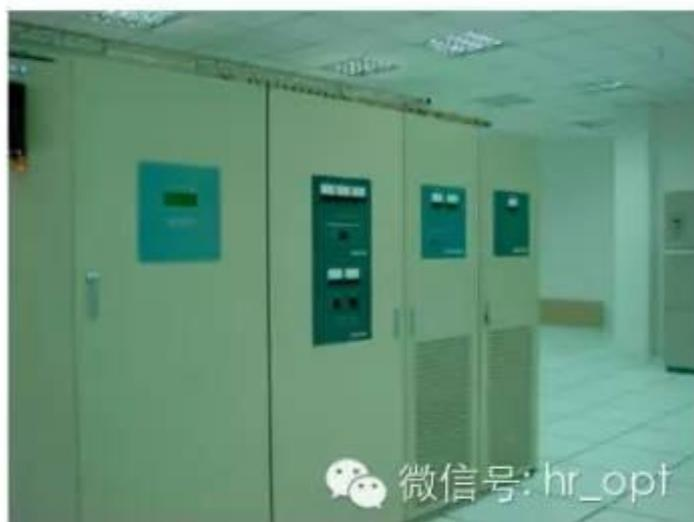
低压(380/220) 配电柜(屏)/低压开关柜是连接降压变压器、低压电源和交流负载的装置,它可以完成市电与备用电源转换、负载分路以及保护、测量、告警等功能
